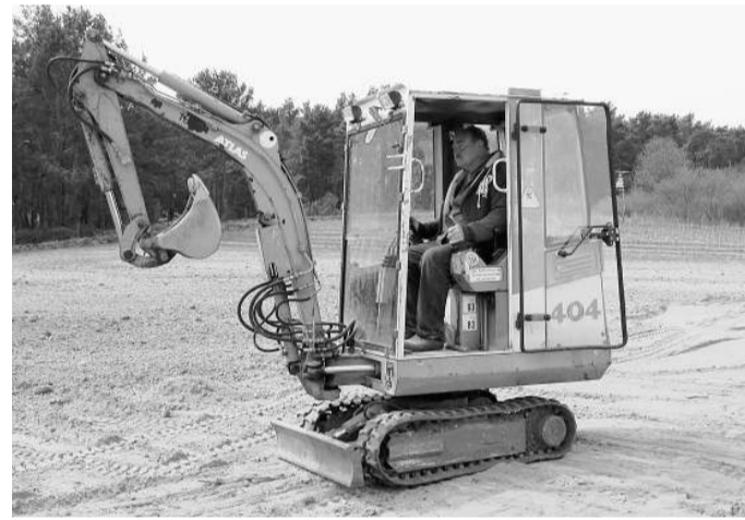
Mit diesem Bagger wurden die Wasserleitungsgräben ausgehoben und wieder zugeschoben.
